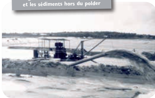
Drague suceuse pour évacuer l'eau et les sédiments hors du polder
